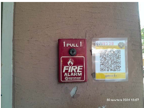
สัญญาณเพลิงไหม้ด้วยมือ (Manual Station)
