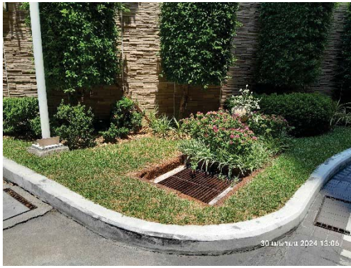
บ่อพักน้ำก่อนระบายออกสู่ท่อระบายน้ำสาธารณะ
